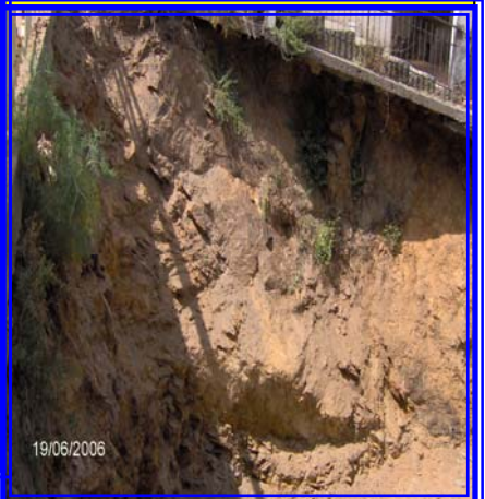
Consolidamento via Casale.
